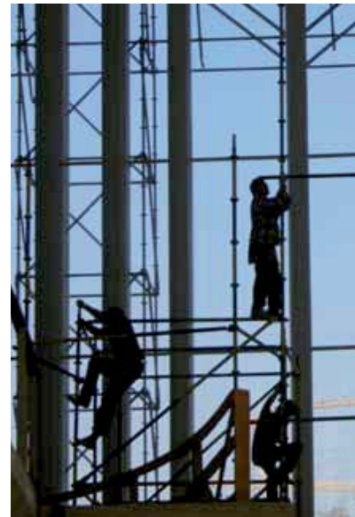
L'entrée principale en construction
